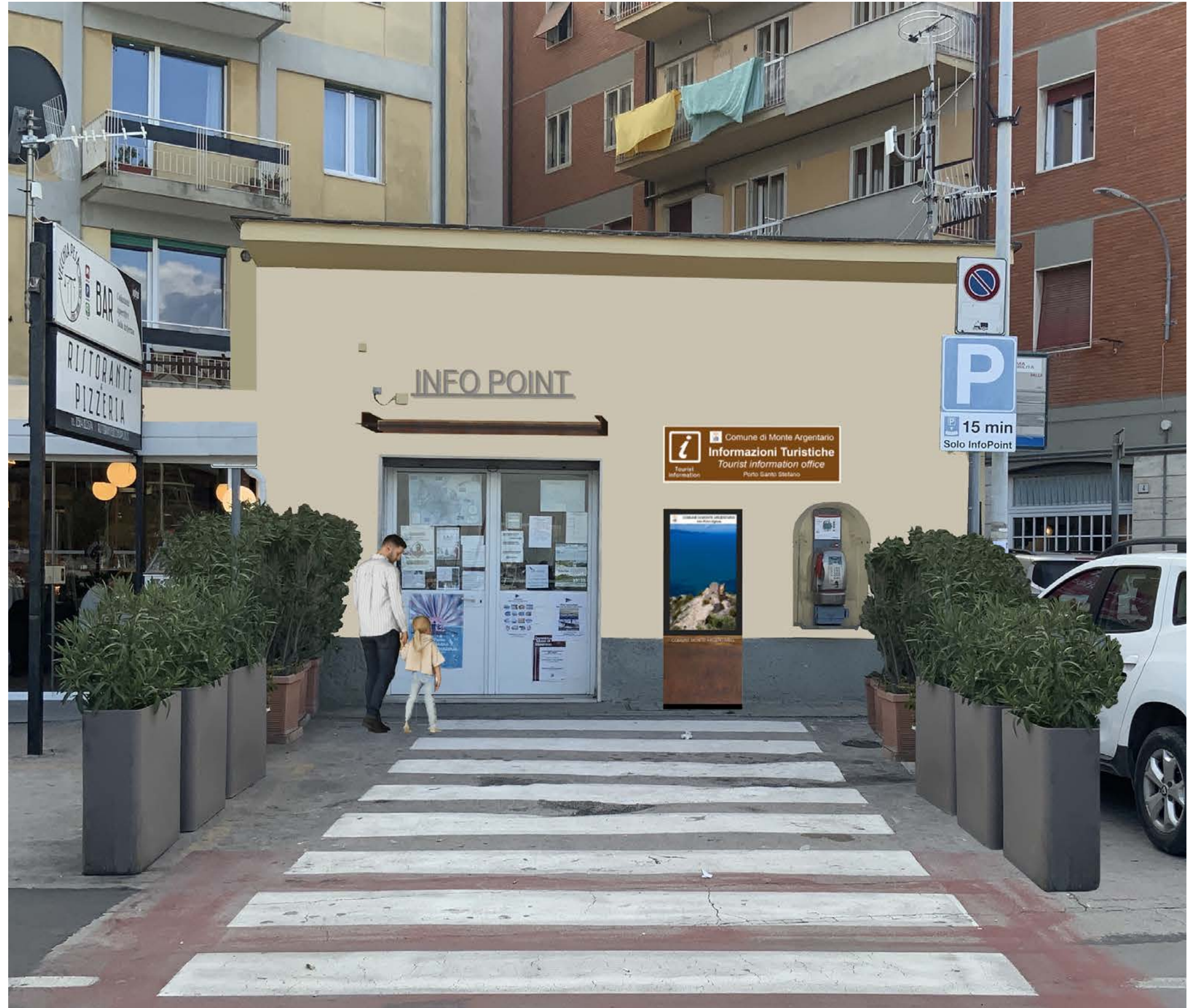
Fig. E6.07 – Info point Porto S. Stefano visto dalle strisce pedonali - simulazione
