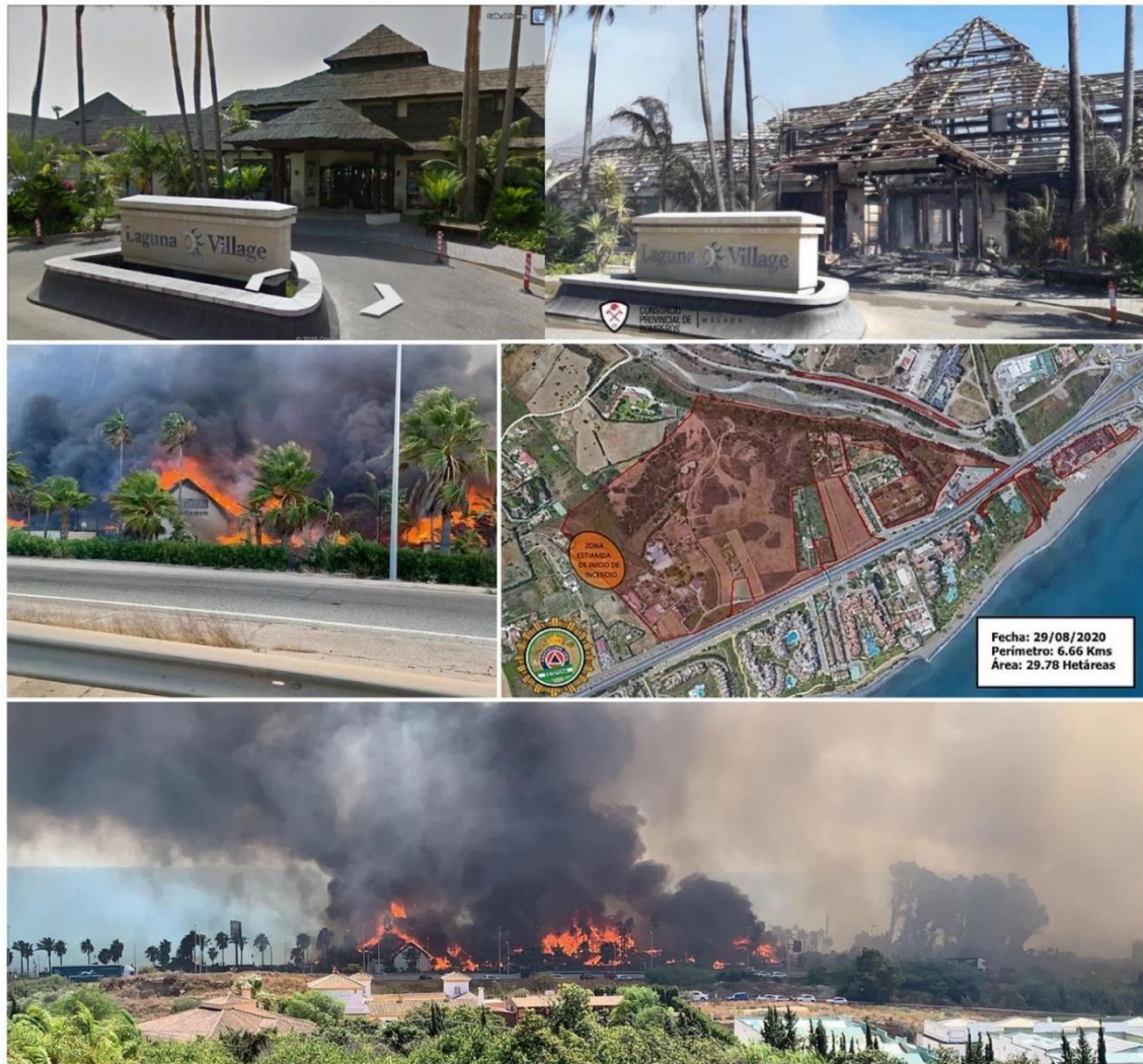
Figura 3.31 - Estapona (Malaga, Andalucía-España), 29/08/2020: incendio boschivo de circa 40 ettari, gli spotting sono precipitati sulle coperture di un villaggio turistico posto ad alcune centinaia di metri che è andato completamente distrutto.
